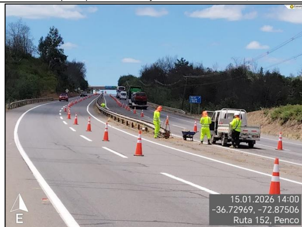
Limpieza de mediana. Ruta 152, Km 61,340.
