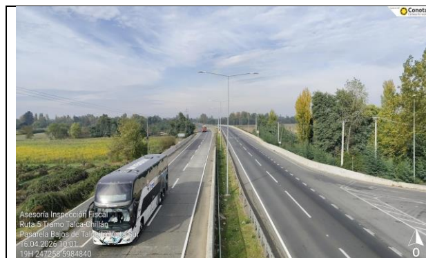
Dm 351,590 – Panorámica Vista Sur Pasarela Bajos de Talquita
