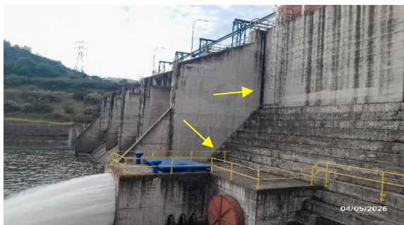
Imagen N°3. Mantenimiento de pintura ejecutado en las líneas hidráulicas de la Válvula Howell Bunger de la Presa Auxiliar.
