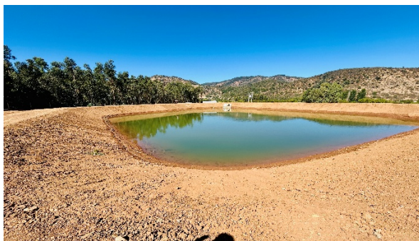
Imagen N°5. Tranque sector La Cabaña ejecutado y finalizado.
