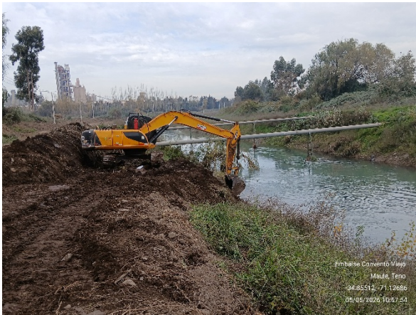
Imagen N°7. Canal Teno Chimbarongo, km 6+980. Mantenimiento tramo con maquinaria pesada- Retiro de material del talud.
