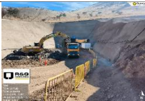
Vista panorámica Túnel Poniente.
