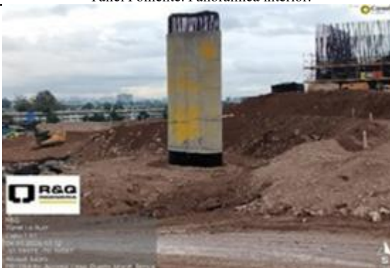
Cepa N°1, Estructura H-1.
