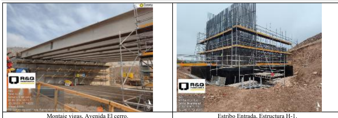
Montaje vigas, Avenida El cerro.
