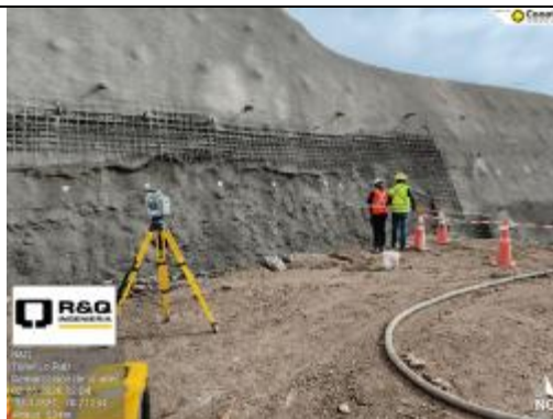
Demarcación de Taludes, Sector Norte.
