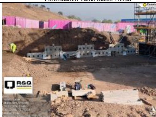
Construcción Muros TEM, Estructura H-2.
