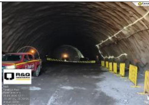
Túnel Poniente. Panorámica interior.
