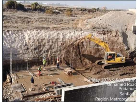
Canalización Estero Las Cruces Enlace Acceso Norte
