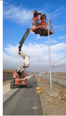
Canalizaciones Eléctricas e Instalación de Luminarias
