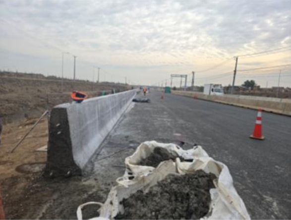
Barreras Laterales In Situ Tramo B2
