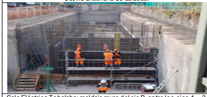
Sala Eléctrica Tobalaba: moldaje muro del eje B, entre los ejes 1 – 3.
