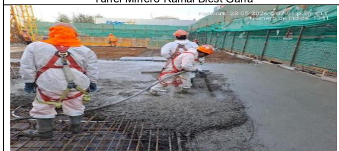
Edificio de Control: Hormigonado de vigas y losa del primer subterráneo.
