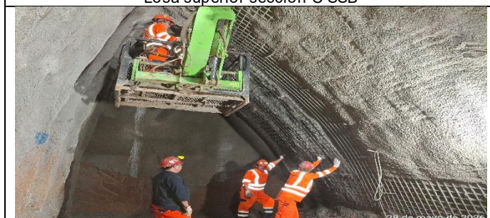
Instalación de Malla HP2 TEO Fase III
