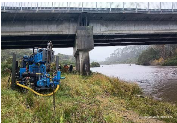
Sondaje – Puente San Antonio
