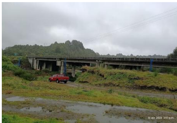
Sondaje – Puente Butalcura
