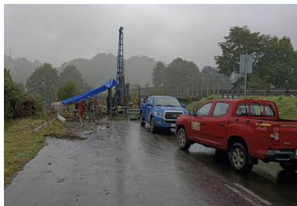
Sondaje – Puente Puntra
