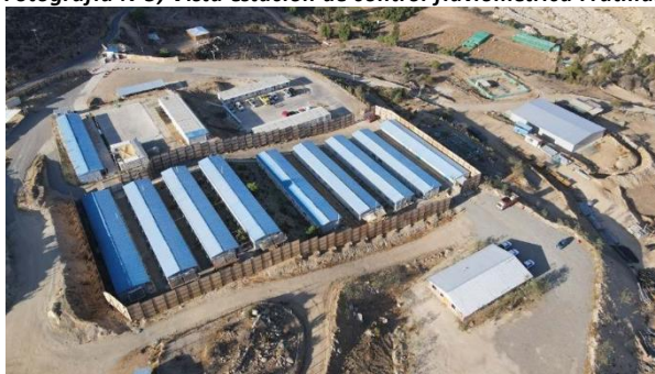
Fotografía N°6 Instalaciones de Faena Soc. Concesionaria CHEC
