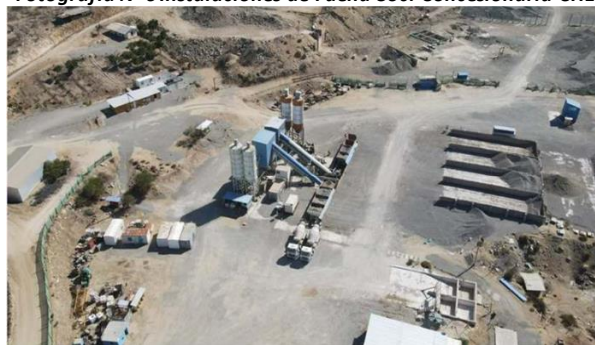
Fotografía N°7. Planta de hormigón
