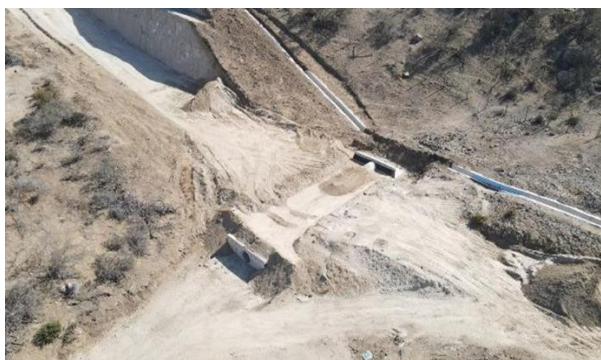
Fotografía N°1, Vista OA N°15. Variante Ruta E-315
