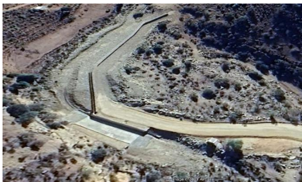
Fotografía N°5, Vista estación de control fluviométrica Frutillar
