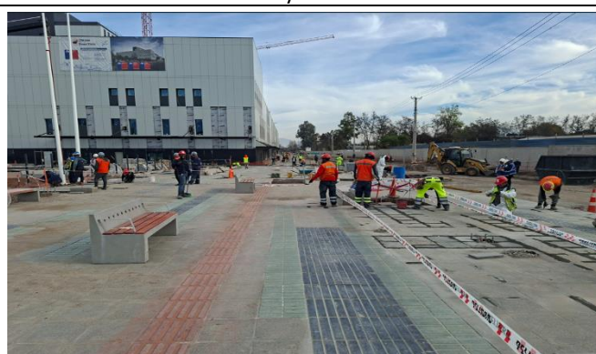
7.- Fachada Oriente Plaza Acceso Peatonal
