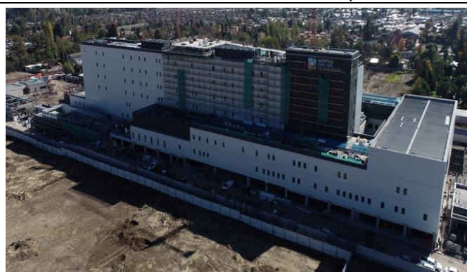
3.- Fachada Sur Edificio Principal HBP
