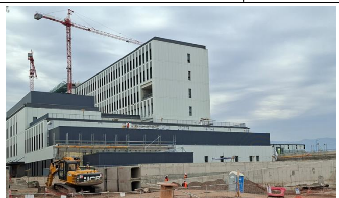
2.- Fachada Poniente de Edificio Principal HBP.
