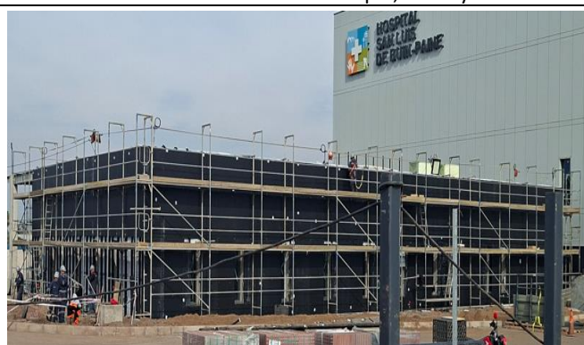
6.- Fachadas Norte y Oriente Edificio SAMU
