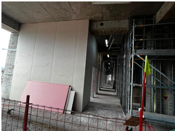
Tabiquería interior Edificio Principal
