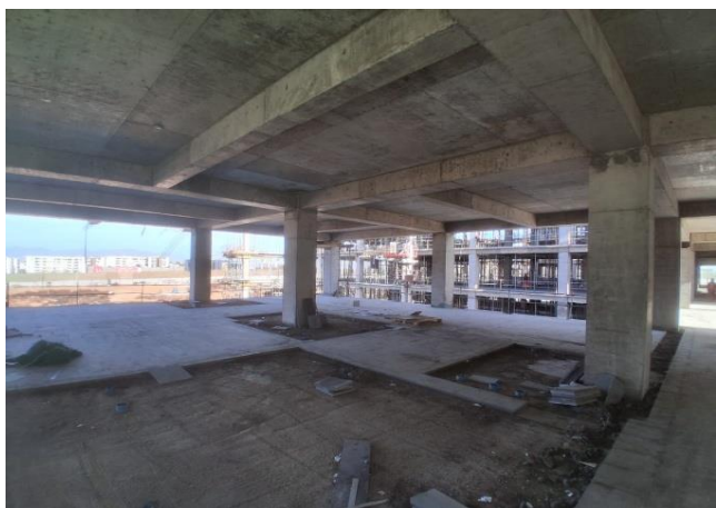
Instalación Baldosas - Nivel 4 (Ejes A-J/18-20)
