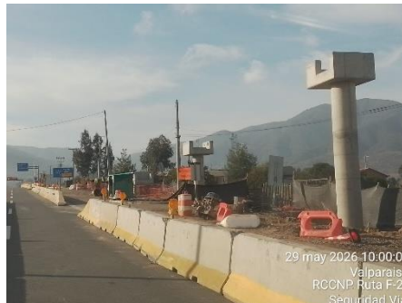
Sector 1-Pasarela Peatonal Dm 18.680 Pilotajes
