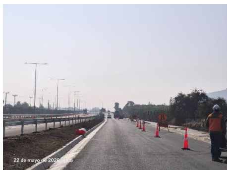
Sector 1-Dm 3.200 a 6.000 app. F-20 Trabajos de Pavimentación Doble Calzada, ejes secundarios
