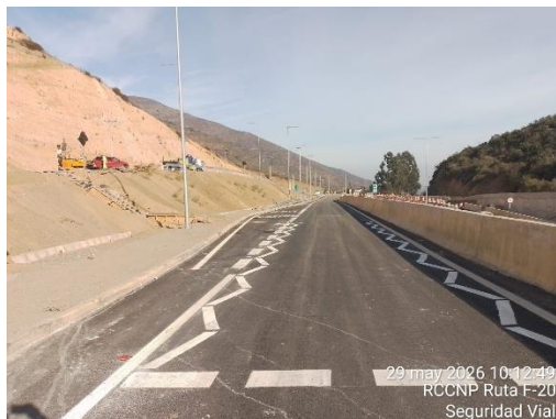
Sector 1-Sector Cumbres Dm. 10.900 app. Trabajos ejes secundarios, lado sur enlace.
