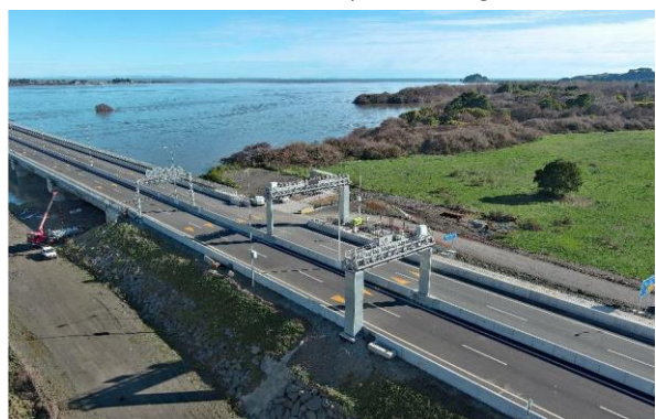
Sector A – Pórticos telepeaje – Hualpén
