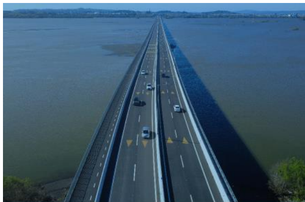
Sector B –Desde estribo Entrada norte – Hualpén
