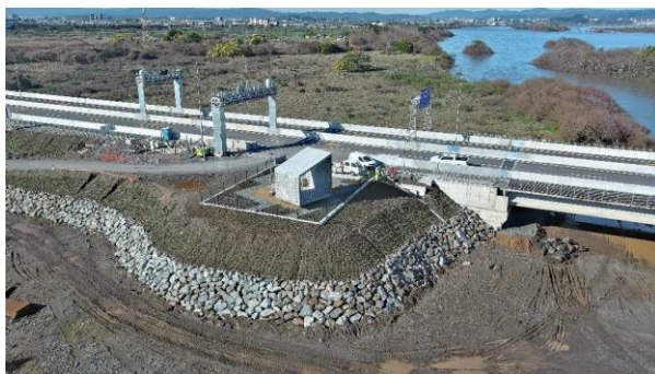
Sector A – Mirador – Hualpén
