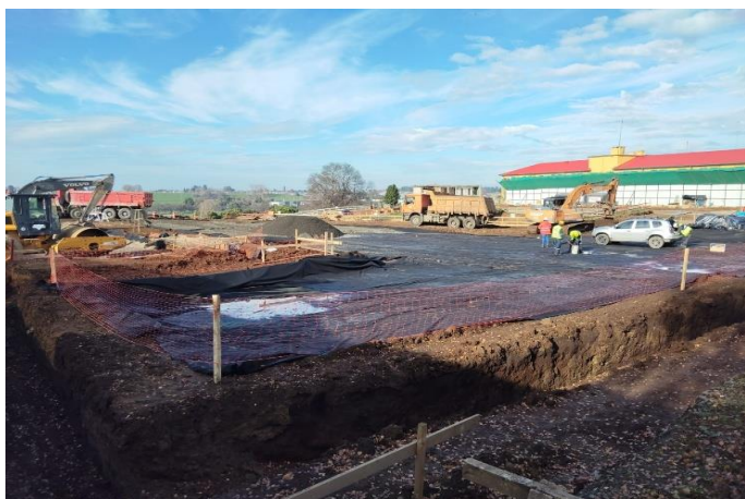
Obras Preliminares Hospital de La Unión
