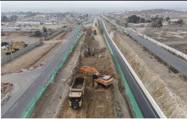
Paso Inferior Avenida Panorámica
