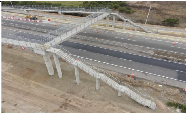
Pasarela Michá Sur
