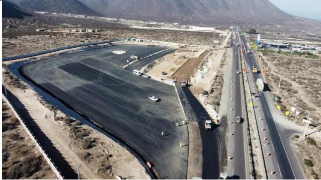
Área Servicios Generales ASG -08 – Km. 455.000.
