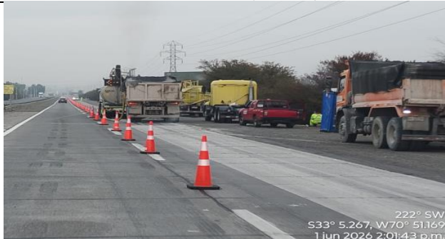
Trabajos de cepillado de pavimentos de hormigón ( Sector de Tilttil Sub-Sector D )
