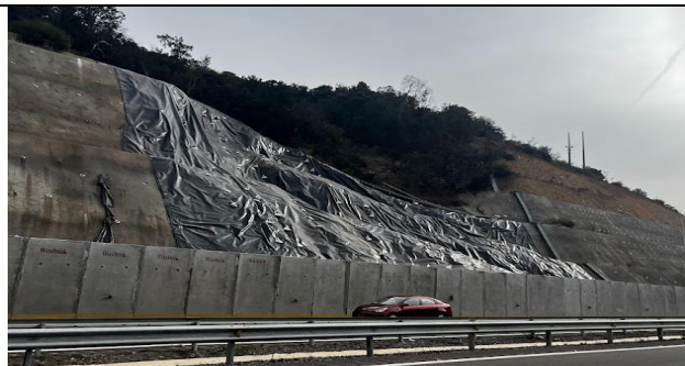
Termino de trabajos de adecuación de proyecto provisorio en taludes El Melón ( Sector 1 )
