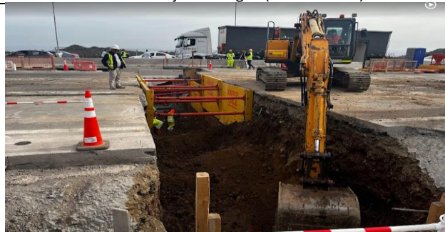
Avance de pasillo técnico Plaza de Peaje Pichidangui ( Sub-Sector F )
