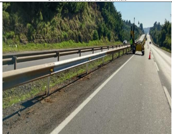
Reparación y Reposición de barreras metálicas de contención
