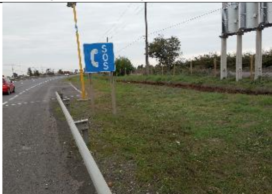
Mantenimiento y conservación de Postes S.O.S
