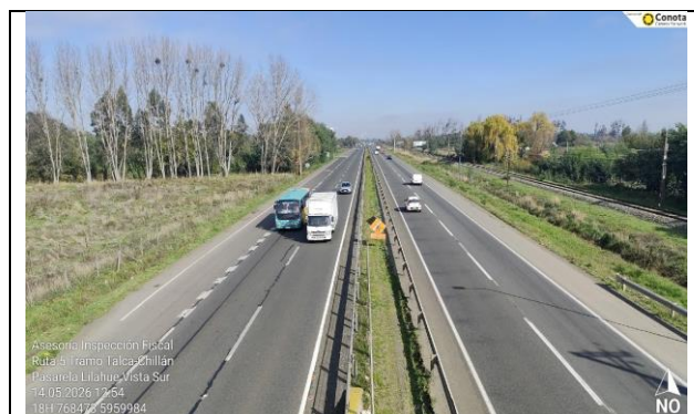
Dm 383,030 – Panorámica Vista Sur Pasarela San Pedro de Lilahue.
