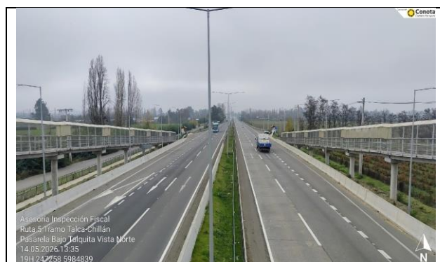
Dm 351,590 – Panorámica Vista Norte Pasarela Bajos de Talquita.
