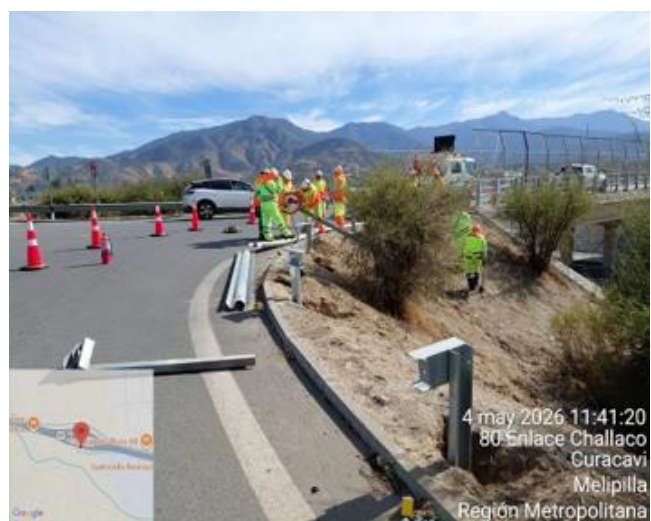
Trabajos de Reposición de Defensas Camineras Simples (ml)
