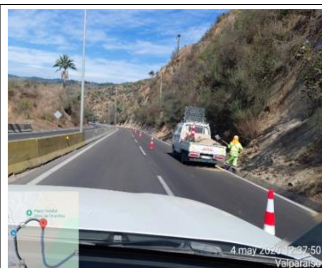
Trabajos de Mantenimiento de sumideros y descargas de agua
