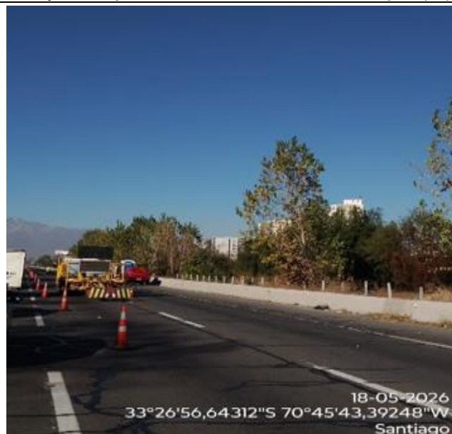
Trabajos de Microaglomerado en Frio [m2]
