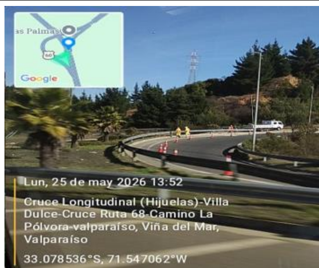
Trabajos Reposición de Defensas Camineras Simples (ml)
