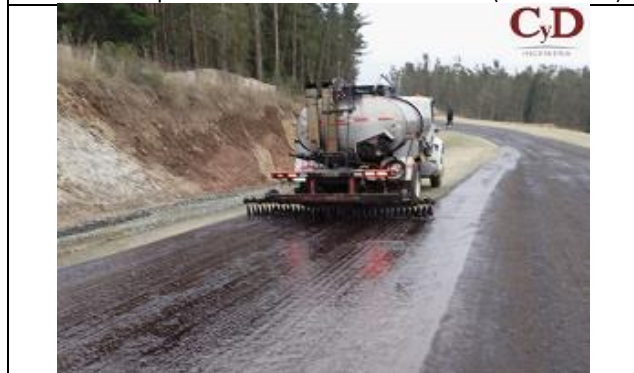
Imprimación tramo B5.2
