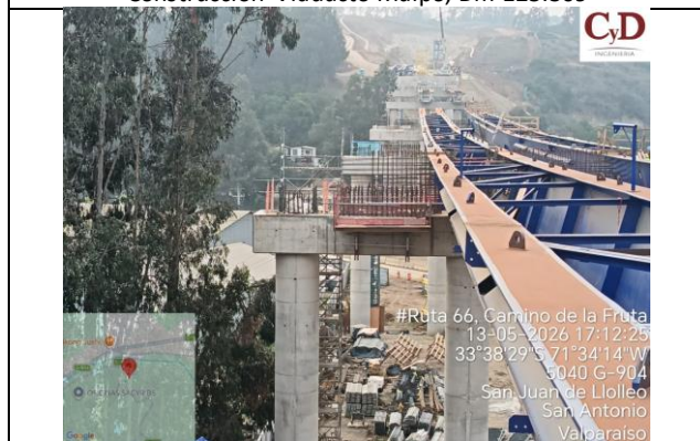
Construcción Viaducto San Juan Dm 130.599 - 130.959
