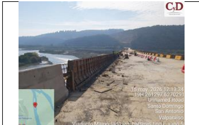
Construcción Viaducto Maipo, Dm 125.309
