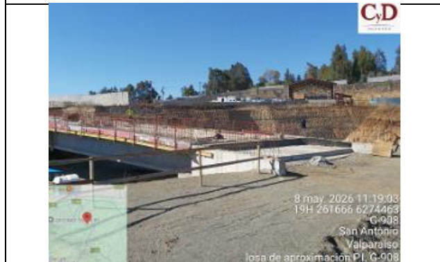
Construcción paso inferior conexión ruta G-908 (dm 130.408)
