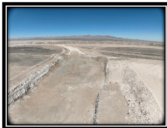
Obras Realizadas Antes de la Paralización
