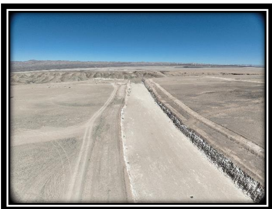
Obras Realizadas antes de la Paralización
