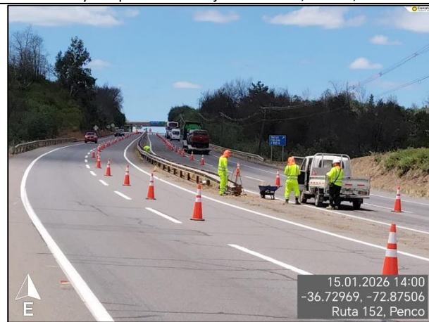
Limpieza de mediana. Ruta 152, Km 61,340.
