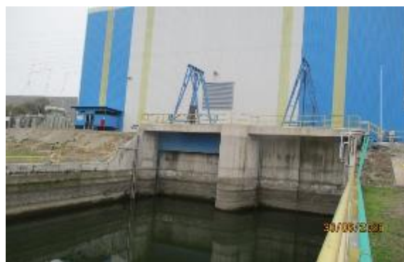
Imagen 4. Central Hidroeléctrica e inicio del canal San Luis. Sin entrega por el momento.
