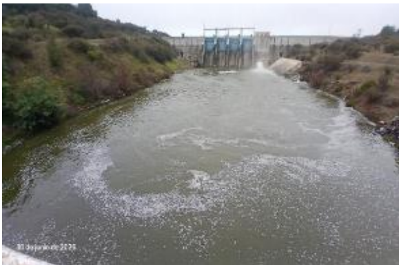
Imagen N°3. Canalón de descarga. Vista general hacia la Presa Auxiliar.
