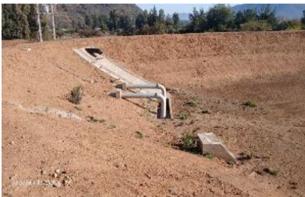
Imagen N°5. Segundo Punto de Impulsión La Cabaña. Vista de chupadores y obras en el interior de tranque.
