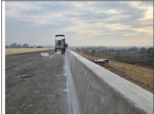
Ejecución barreras laterales In situ B3
