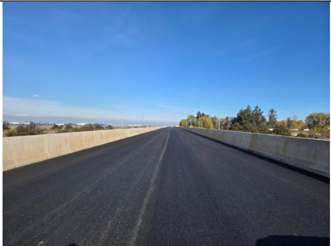
Asfaltado Tramo B3
