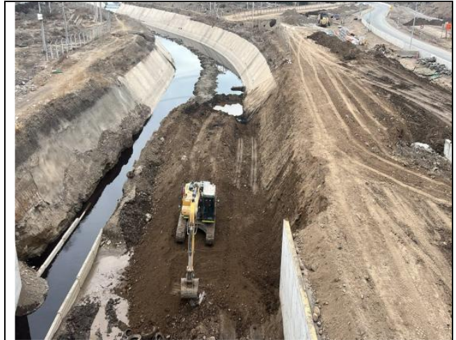
Canalización Estero Las Cruces Enlace Acceso Norte
