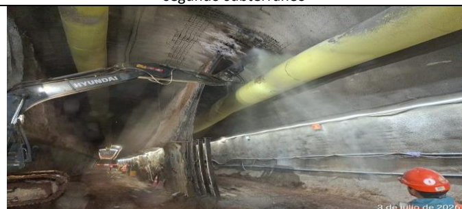
Demolición Muros Temporales Túnel Av. El Valle.
