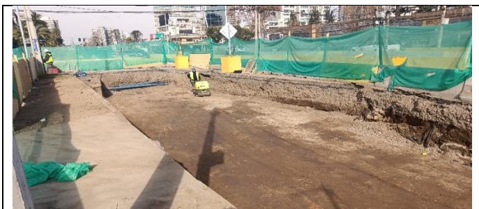
Ensanche calzada sector San Vicente de Paul
