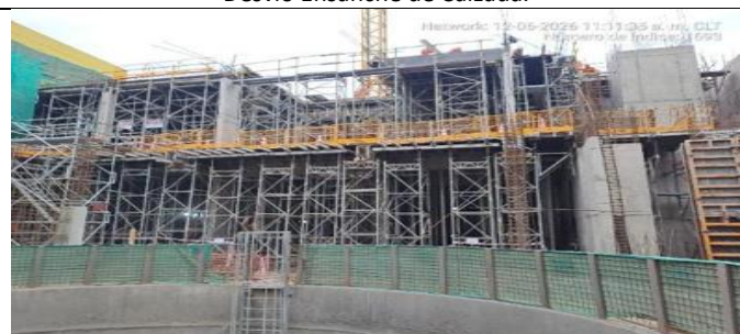
Edificio de Control: Vista parcial de Sur a Norte del primer y segundo subterráneo
