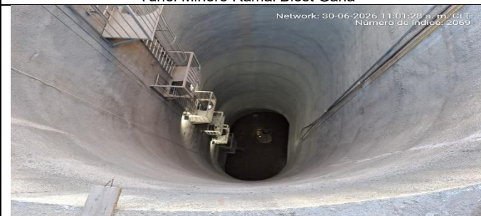
Pique de Ventilación Calle Nueva: Vista hacia el interior del Pique en construcción.
