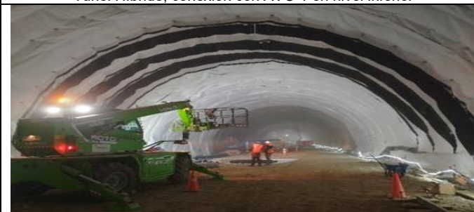
TVEP, frente 1, instalación de geomembrana impermeabilizante
