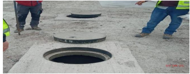
MantenCIÓN: MantenCIÓN Cámaras Colectores.
