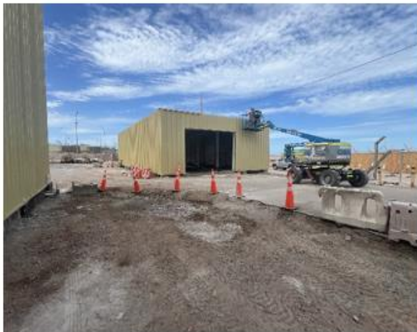
Instalación revestimiento Galpón AVC
