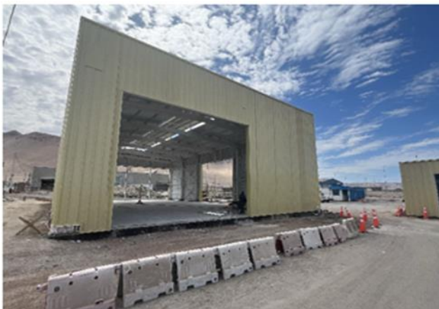
Colocación revestimiento Galpón Aduana
