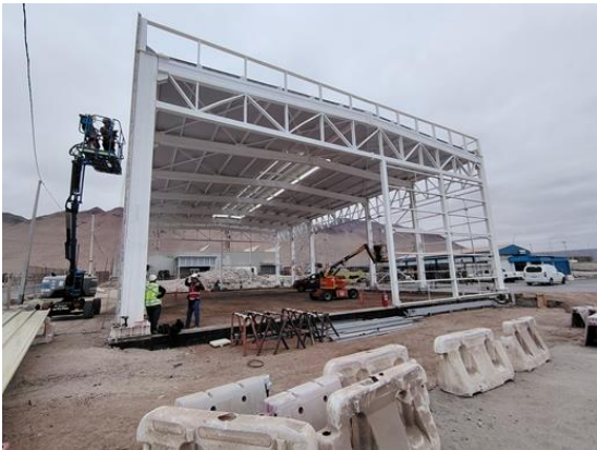
Colocación revestimiento exterior Galpón Aduana
