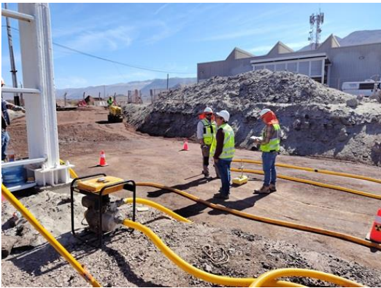
Preparación sub base vialidad acceso Galpón Aduana
