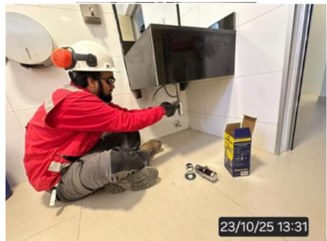
Mantenión Grifería Baños Públicos
