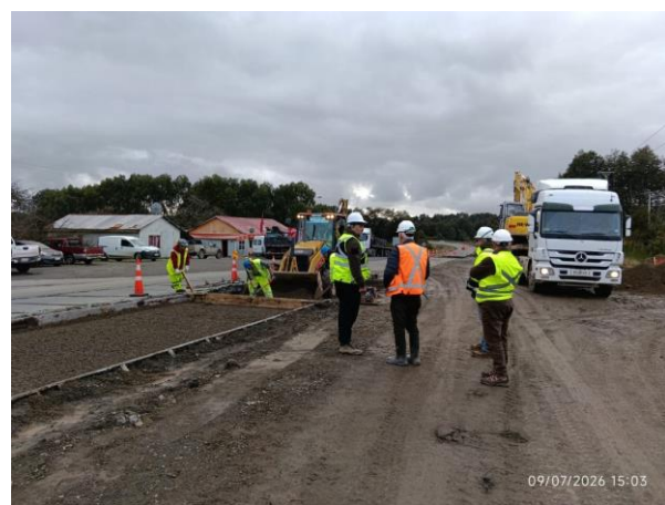
Reposición de Losas
