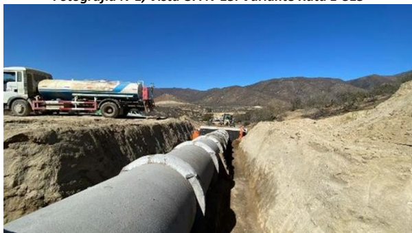
Fotografía N°2, Rellenos estructurales OA N° 21. Variante Ruta E315
