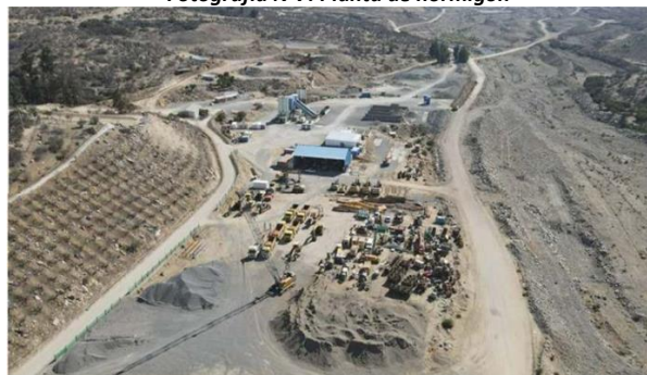
Fotografía N° 8. Lote 7, taller de maquinaria
