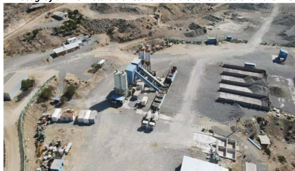
Fotografía N°7. Planta de hormigón
