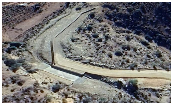
Fotografía N°5, Vista estación de control fluviométrica Frutillar
