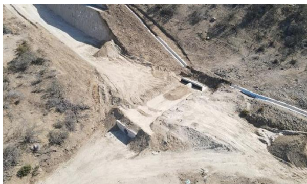
Fotografía N°1, Vista OA N°15. Variante Ruta E-315
