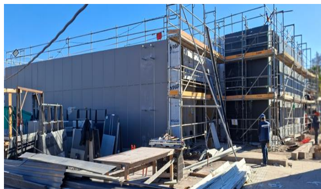
7.- Fachadas Sur y Oriente Sala Cuna (Costado Poniente del terreno)
