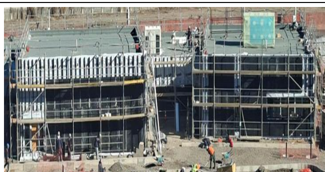
8. Fachada Sur y Oriente Sala Cuna (Costado Poniente): Instalación revestimiento con piedra sinterizada.
