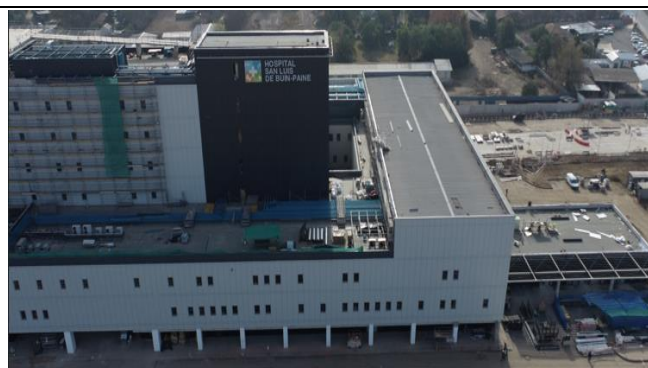
2.- Vista aérea de fachada Suroriente Edificio Principal HBP.
