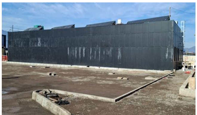
10. Fachada Norte REAS (Costado Surponiente del terreno).
