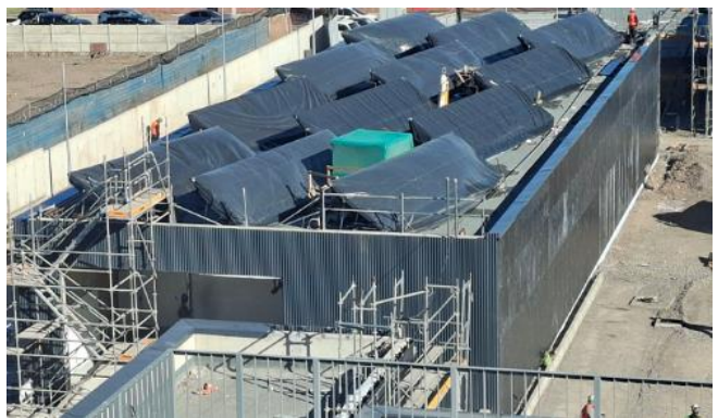
11.- Fachada Norte y Oriente REAS (Costado Surponiente del terreno).
