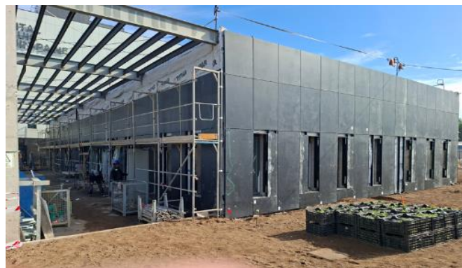
12.- Fachada Sur y Oriente SAMU : Instalación revestimiento con piedra sinterizada.
