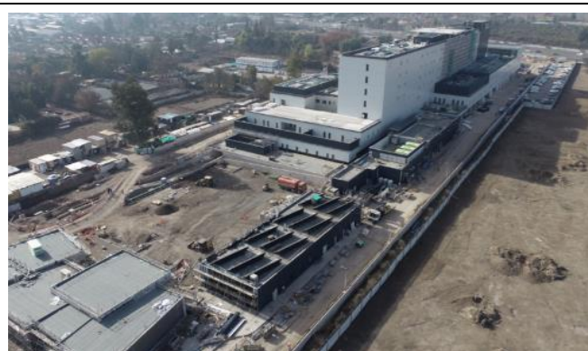
5.- Vista aérea de Fachada Sur y Poniente de Edificio Principal HBP y Edificio REAS y Sala Cuna (Sector estacionamiento superficie).
