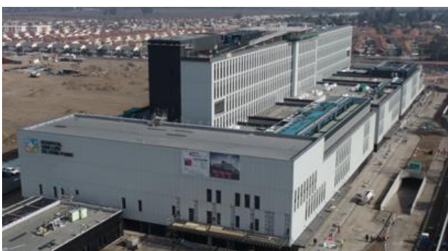
1.- Vista aérea de fachada Oriente y Norte Edificio Principal HBP.
