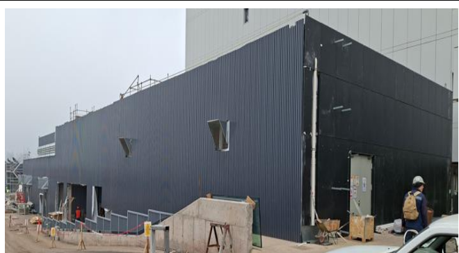
9. Fachada Sur y Oriente Edificio Principal : Instalación gatera acceso a cubierta.
