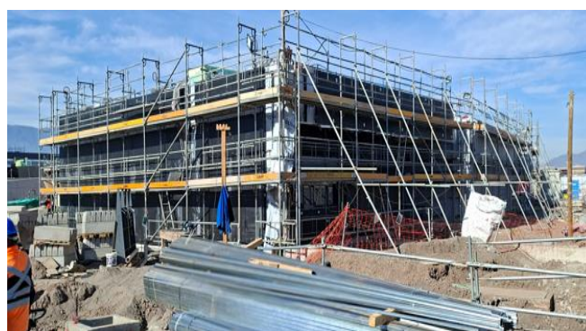
6.- Fachadas Norte y Poniente Edificio Sala Cuna: Instalación revestimiento con piedra sinterizada.
