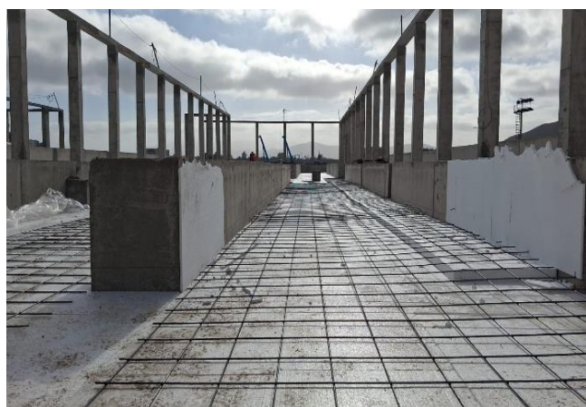
Ejecución de Sobrelosas - Nivel 4 (Sector E)
