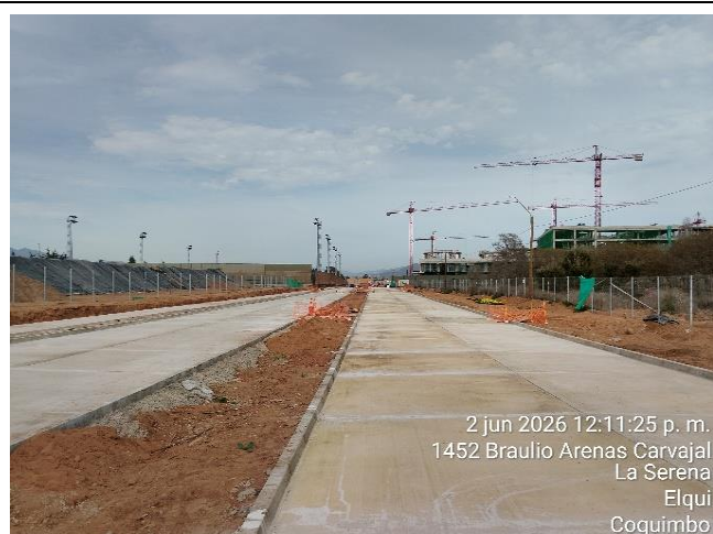
Obras de Urbanización Av. Rodolfo Wagenknecht
