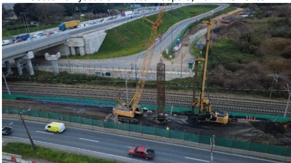
Sector C-Izaje Malla Pilote 2, Cepa 3- Ramal Oriente
