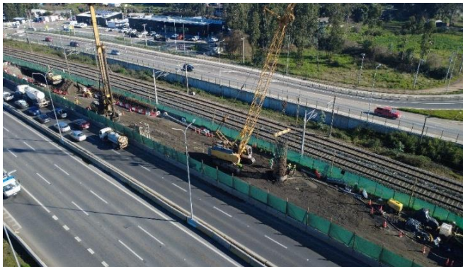
Sector C-Izaje Malla de Pilote 4 Cepa 3, Ramal Poniente
