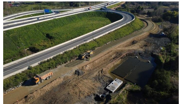
Sector Biofiltro N°6 - Compactación de Base Granular
