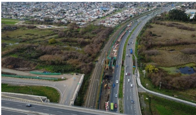
Sector C-Ejecución Pilote 2 Cepa 3, Ramal Oriente
