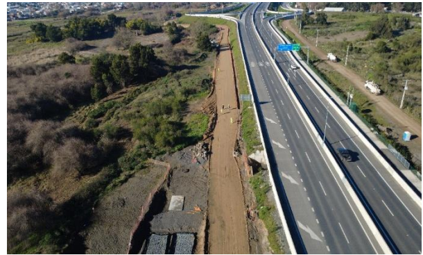
Sector Biofiltro N°4 - Excavación Canaletas ALL
