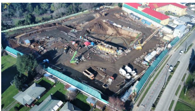
Obras Preliminares Hospital de La Unión
