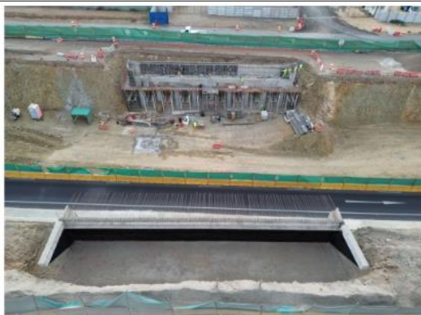
Paso Inferior Avenida Panorámica
