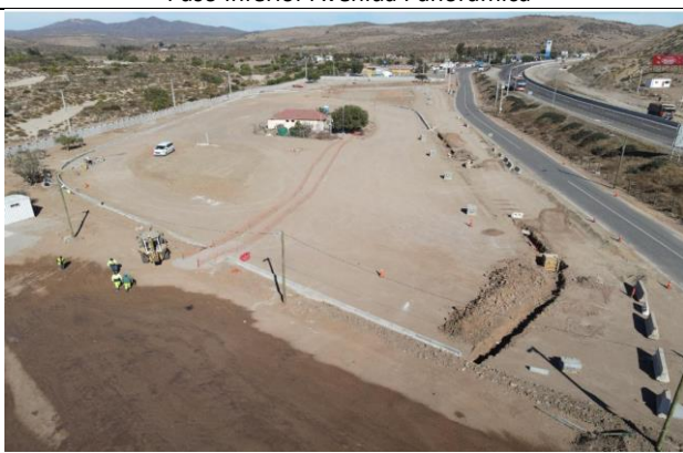
Área Servicios Generales ASG -05 – Km. 370.800.
