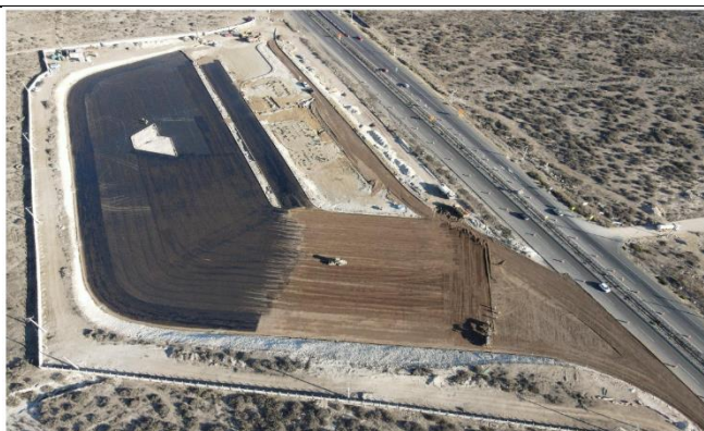
Área Servicios Generales ASG -08 – Km. 455.000.
