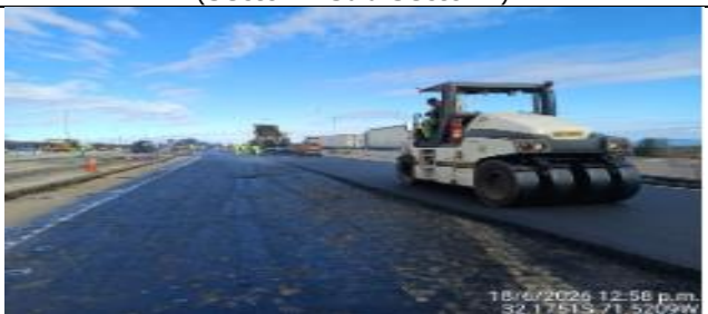
Trabajos de pavimentos asfálticos (Sector de Pichidangui) (Sector 2-Subsector F)
