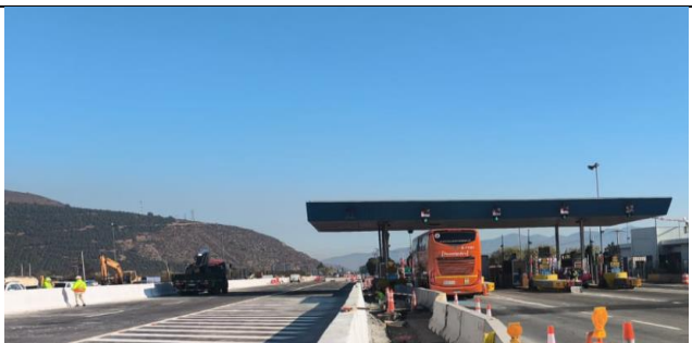
Avance de Obras en Plaza de Peaje Las Vegas (Sector 2-Sunsector E)
