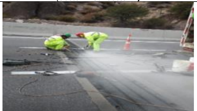
Trabajos en juntas de dilatación Viaducto Las Chilcas (Sector 2-Subsector E)
