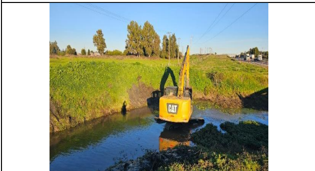
Conservación del Drenaje y Saneamiento de la Faja Vial
