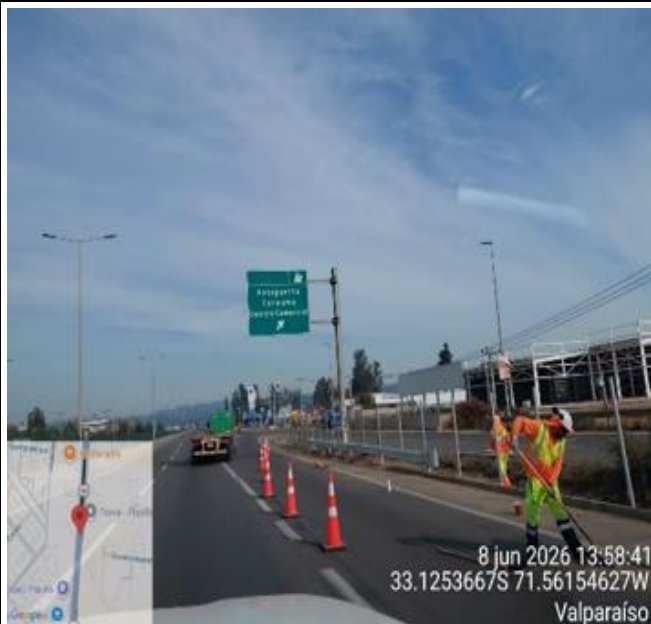
Trabajos de Reposición de Defensas Camineras Simples [ml]
