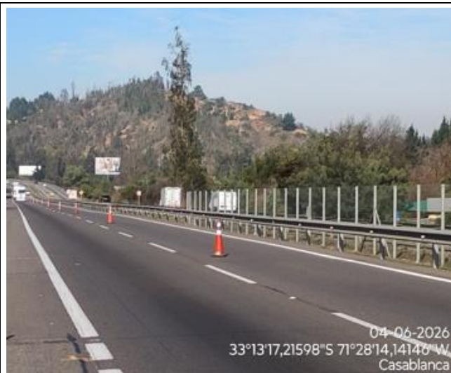
Trabajos de Retiro manual de basuras y desechos [m3]
