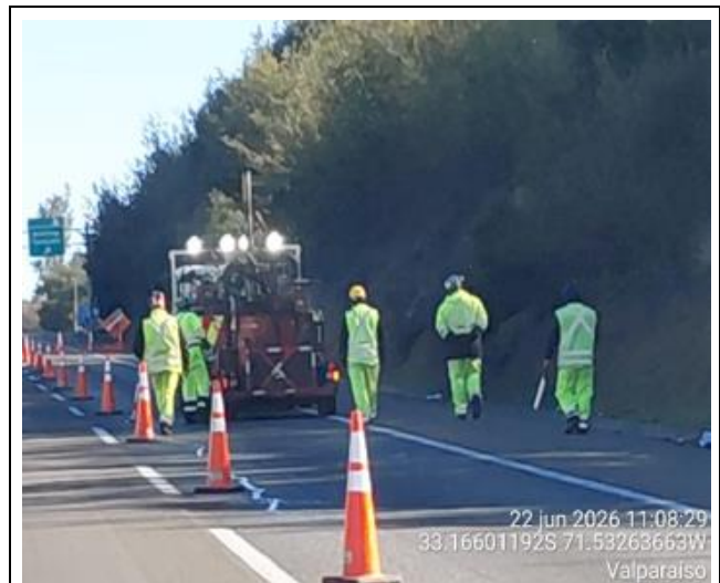
Trabajos de Sellado de Grietas R68
