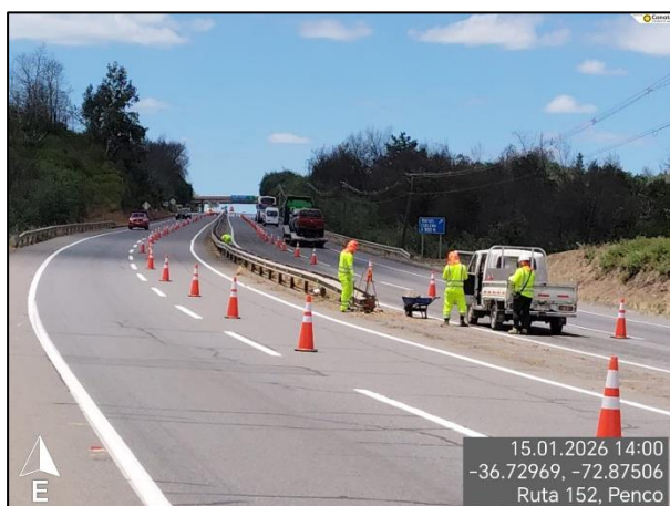
Limpieza de mediana. Ruta 152, Km 61,340.
