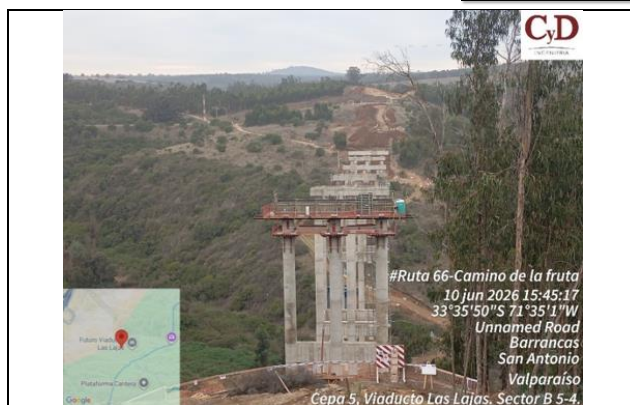
Construcción Viaducto Las Lajas (dm 136.200 - 136.652)
