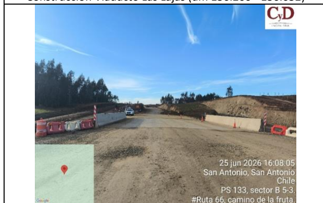
Construcción Paso Interpredial 133
