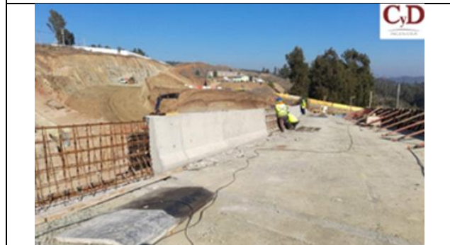
Construcción paso inferior conexión ruta G-908 (dm 130.408)
