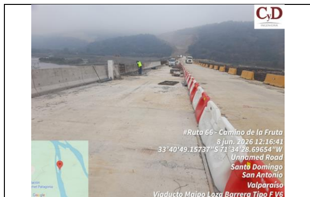
Construcción Viaducto Maipo, Dm 125.309
