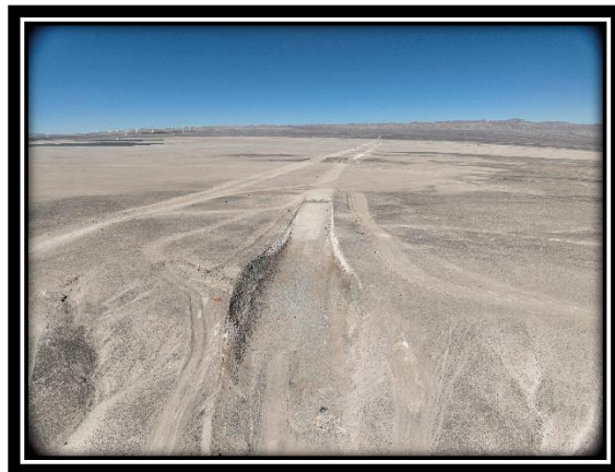
Obras Realizadas antes de la Paralización
