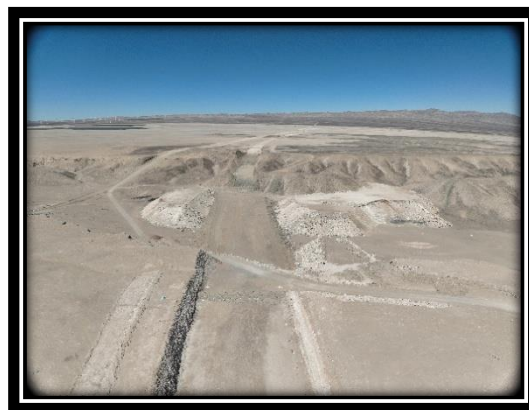
Obras hasta antes de Paralización Sector B
