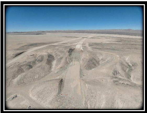
Obras Realizadas antes de la Paralización
