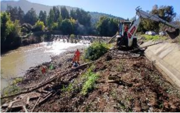
Imagen N°7. Mantenimiento Canal Lolol Sur, km. 9+700
