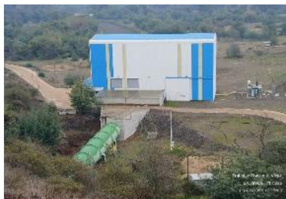
Imagen 4. Central Hidroeléctrica e inicio del canal San Luis. Sin entrega por el momento.
