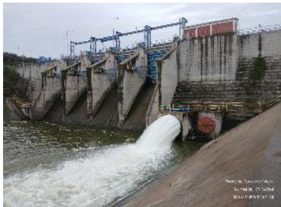
Imagen N°3. Descarga a través de la válvula Howell Bungler en la Presa Auxiliar.
