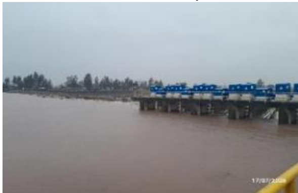
Imagen 2. Bocatoma Teno. (17.07.2026). Barrera móvil y compuertas cerradas y nivel de poza en 308,95 m.s.n.m. a las 10:00 horas. Caudal entrante a la poza 110 m3/s.
