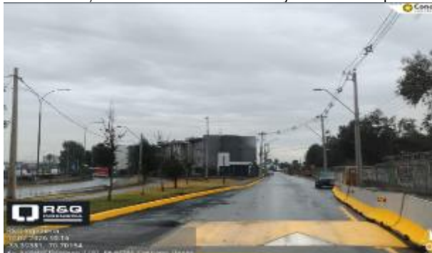
Desvío Apóstol Santiago Poniente, obras de ensanchamiento de calzada calle Los Diamantes.
