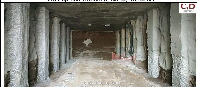
Trinchera Salida Simón Bolívar (SSB)
