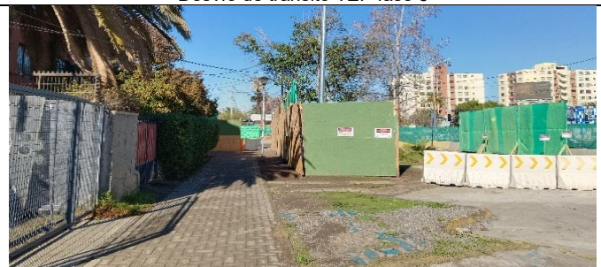
Desvío Ensanche de Calzada.
