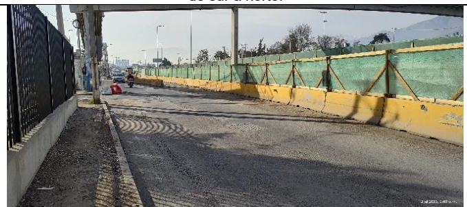
Desvío de tránsito TEP fase 3
