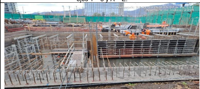
Sala Eléctrica Tobalaba: Vista general de los trabajos que se ejecutan en el lugar.
