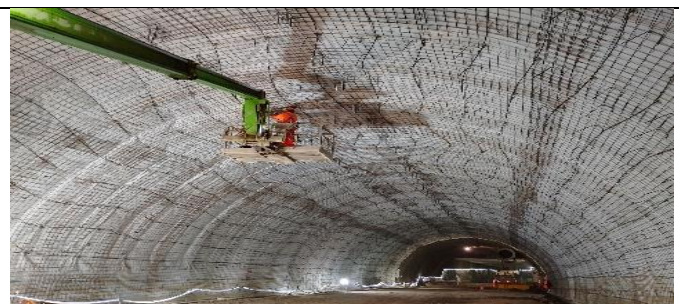
TVEP, frente 1, avance en instalación de geomembrana impermeabilizante y malla para revestimiento HP1
