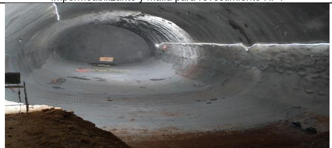
TVEP, frente 2, avance en confección de contrabóveda, fases 5, 6 y 7 de sur a norte.
