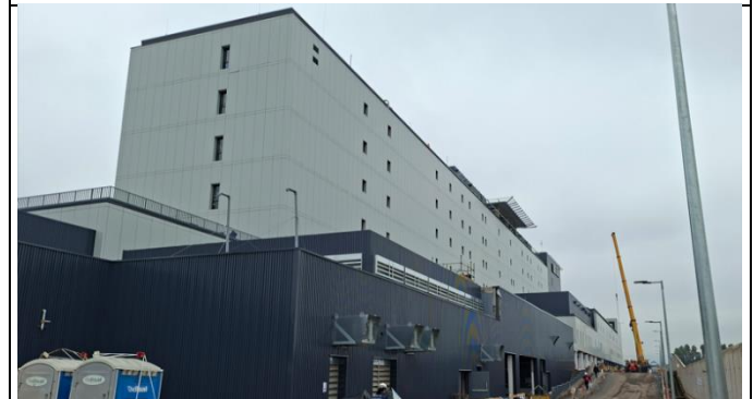
7.- Fachadas Sur poniente de Edificio Principal HBP.
