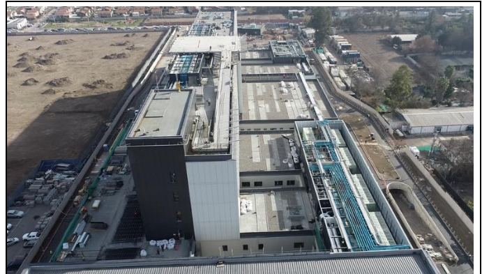
5.- Vista aérea de cubiertas de Edificio Principal HBP.
