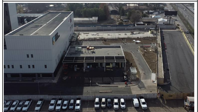
8. Fachada Suroriente SAMU y parte de Edificio Principal HBP.
