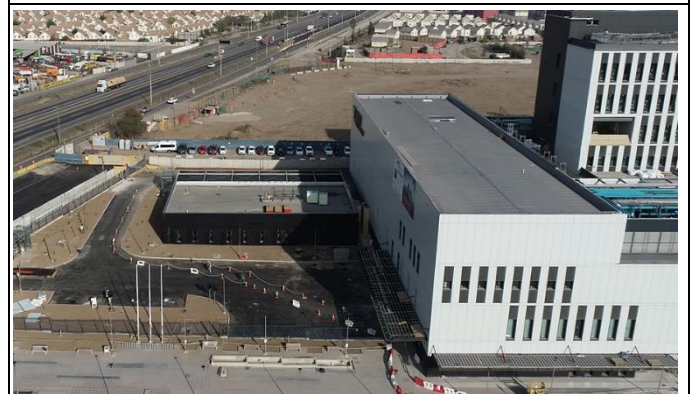
6.- Fachadas Nororiente SAMU y parte de Edificio Principal HBP.
