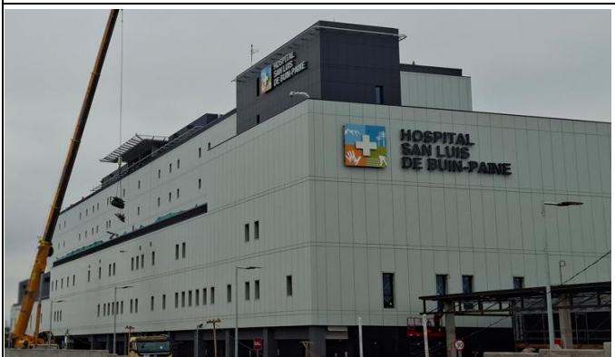
4.- Fachada Sur y Oriente de Edificio Principal HBP.
