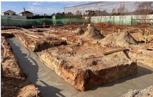
Inicio de obras en sector de Sala Cuna al Nororiente del terreno
