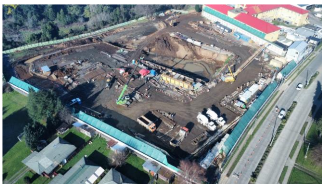
Obras Preliminares Hospital de La Unión
