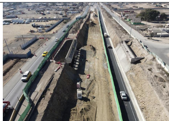
Paso Inferior Avenida Panorámica
