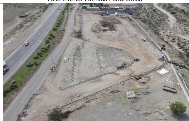
Área Servicios Generales ASG –05 – Km. 370.800.
