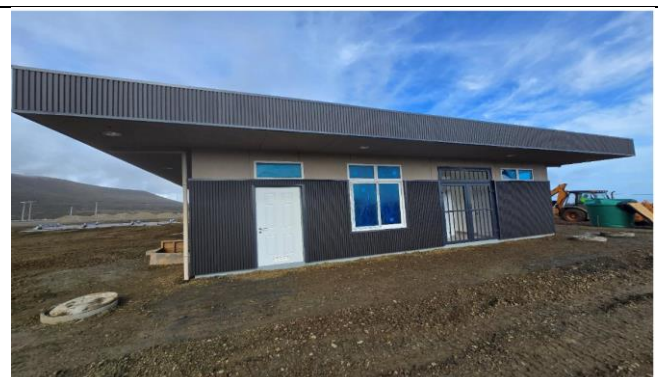
Área Servicios Generales ASG –01 – Km. 250.000.
