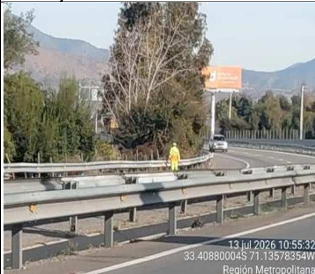
Trabajos de Retiro Manual de basura y desechos R 68
