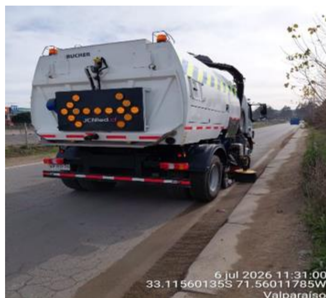
Trabajos de Limpieza mecanizada de bermas y calzadas R68
