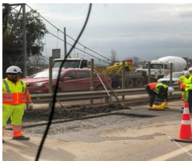
Trabajos de Emergencia (Evento en ruta) R-68
