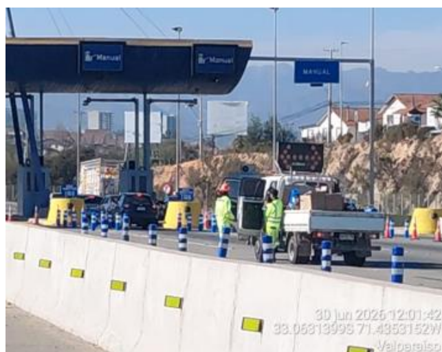
Trabajos de Mantenimiento Separadores tipo Hito Delineador R68
